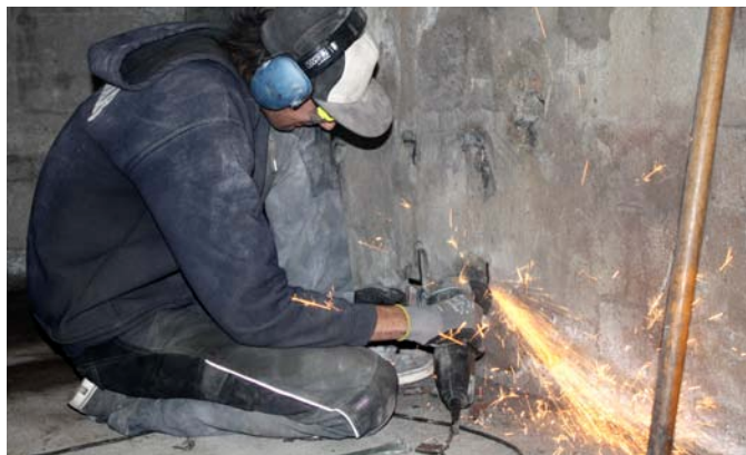
Einsatz beim Bau der SinnBOX.
