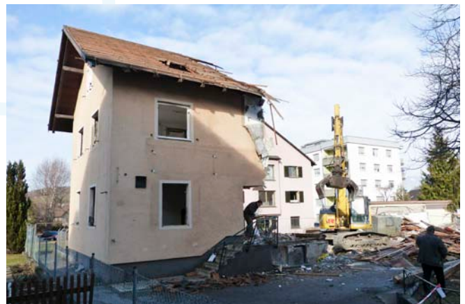
Abbruch Wohnheim Mühlegasse 26.01.2012
